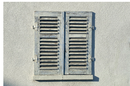
Fensterladen mit Holzlamellen
