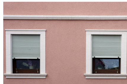
Verdeckt angebrachter Rollladenkasten
