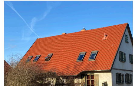
Ruhig angeordnete Dachliegende Fenster
